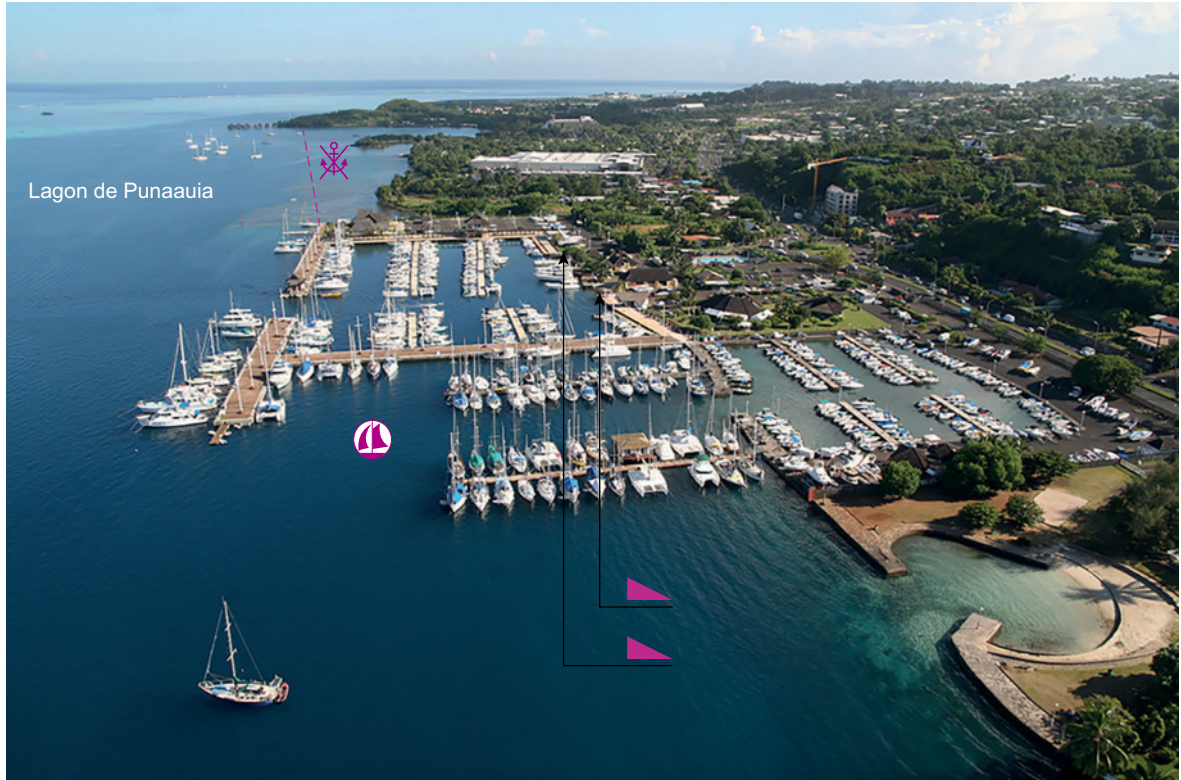
5.2.4.1.C. — Port de plaisance de Marina Taina, au Nord (port autonome de Papeete).
